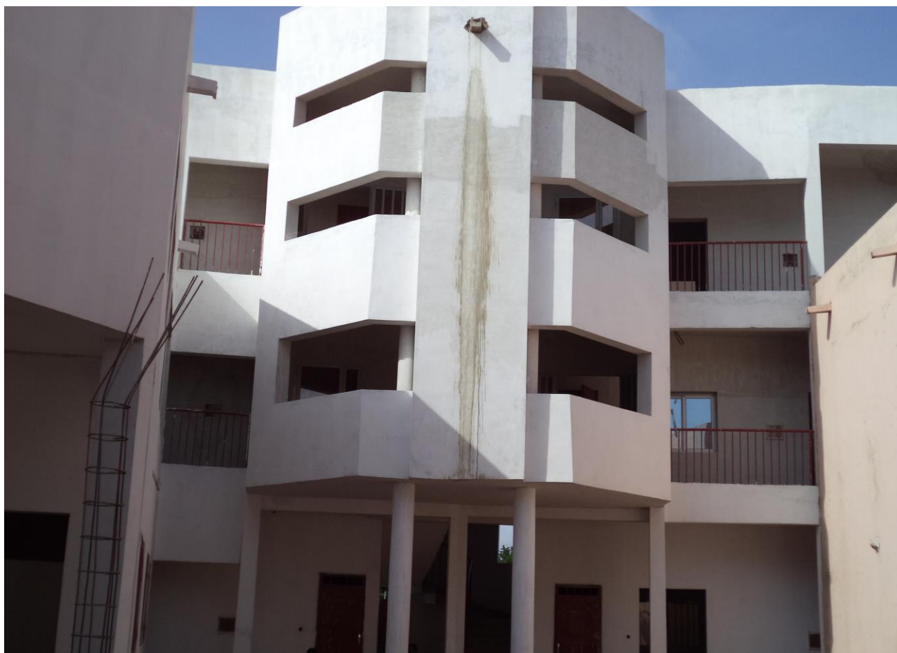
Les travaux de Construction et Réhabilitation de la Direction de la Cellule de Planification et Statistique secteur Equipement, Transports et Communication permettant aux agents d'avoir de bureaux adéquats.
