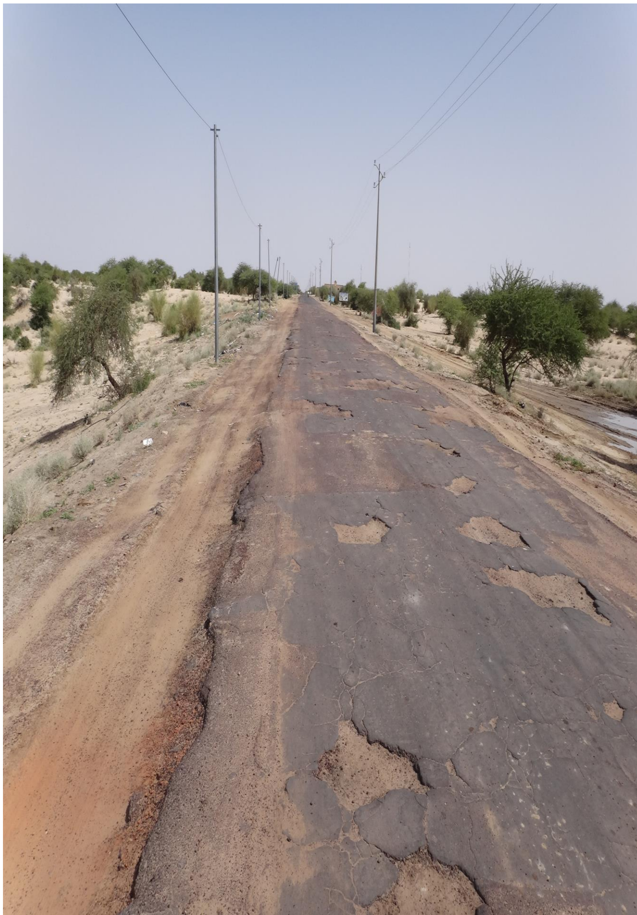
Route de dégradée en instance d'être réhabilitée
